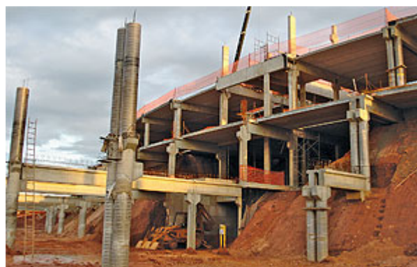
A implantação em três níveis circulares respeitava a declividade do terreno e evitava o deslocamento de terra, com redução dos impactos ambientais
