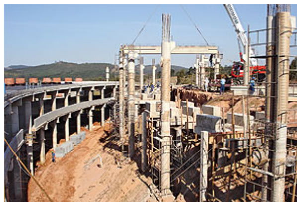
Peças estruturais de concreto armado protendido eram pré-fabricadas na porção superior do terreno; fôrmas de pilares circulares eram montadas sobre o bloco de fundação e depois concretadas
