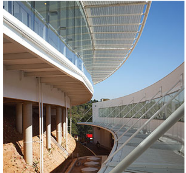
Taludes à vista são importante elemento arquitetônico; no terceiro anel, pilares nascem no meio dele, o que exigiu escavações manuais
